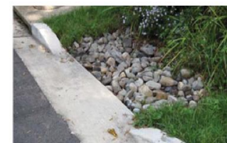
[AL CENTRO, IN BASSO] Fig. 1.4: copertura del substrato con ciottoli in corrispondenza dei punti di ingresso dell'acqua. Fonte: (CVC, 2010)
