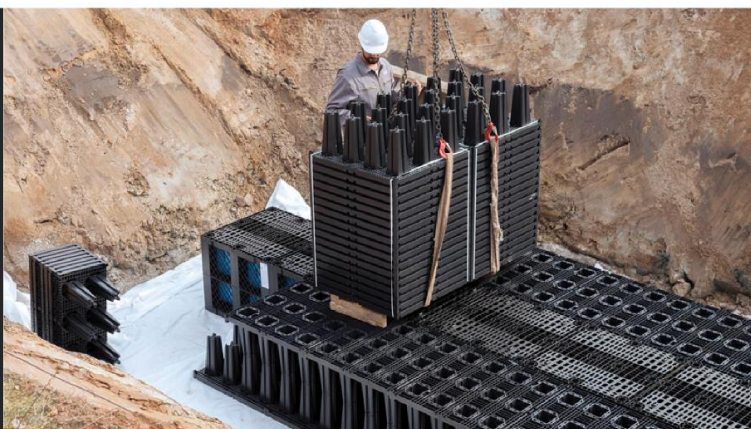
Fig. 1.10: installazione di sistemi geocellulari. Fonte: https://hydro-int.com/
